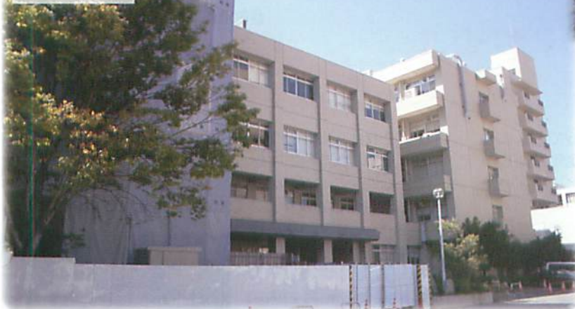
保健学科改修中
